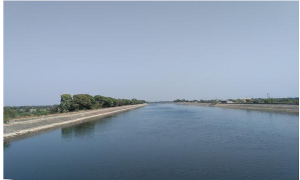
Narmada Main Canal
